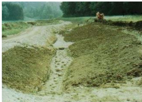
施工中 (写真提供：チューリッヒ建設局)
