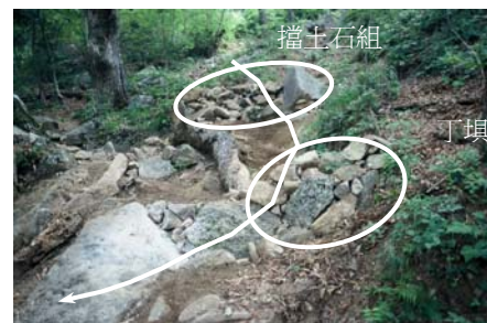
完工後。從山谷方向仰望崩塌斜坡上配置的丁填石組與擋土石組。原本施工前在斜坡上的大小石，因被利用爲石組材料，此時在斜坡已沒有這些石材了。
