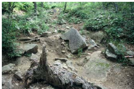
着手前。登山者は、縦一文字の崩壊斜面を横断していた。この中間にとどまっていた巨石を両脇にして、緩やかなアーチ状の石垣を組み、土砂止めとした。
