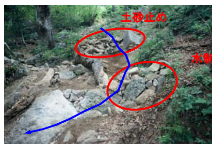
完成。谷側から崩壊斜面に施工した水制石垣、土砂止め石垣を仰ぎ見た状態。着手前、斜面に在った大小の浮石は、石垣材に使用して無くなっている。
