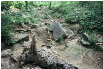
施工前。登山者必須橫跨呈一直線的縱向崩塌斜坡。以停在此中間的巨石爲兩端，配置拱形狀石組，以利擋土。
