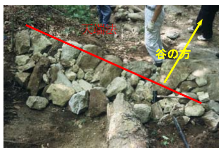
完成。石垣の天端法線を谷の方向に向かい直角に設定した。また上方からの水勢を弱めるため天端面を山手に下げ、石垣の裏からも排水するよう裏込め栗石を厚くした。
