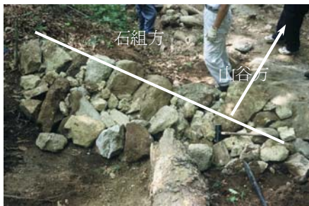
完工後。石組方向是取與山谷方向垂直的角度設定。爲了減弱自上方的水勢，石面朝靠山方向下垂配置，並在石組後方敷設厚實的小石，以利排水。
