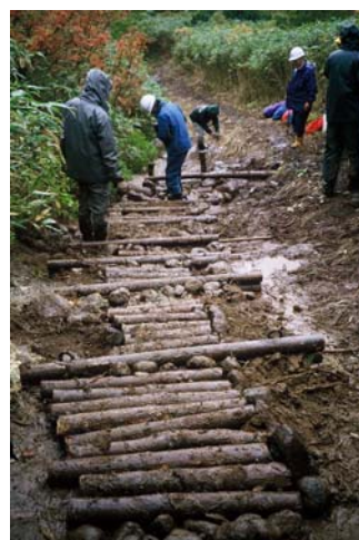
みお筋の方向が保全された丸太階段完成
