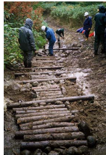
維持主要水脈的方向而為維護主要水脈流向而敷設的圓木階梯
