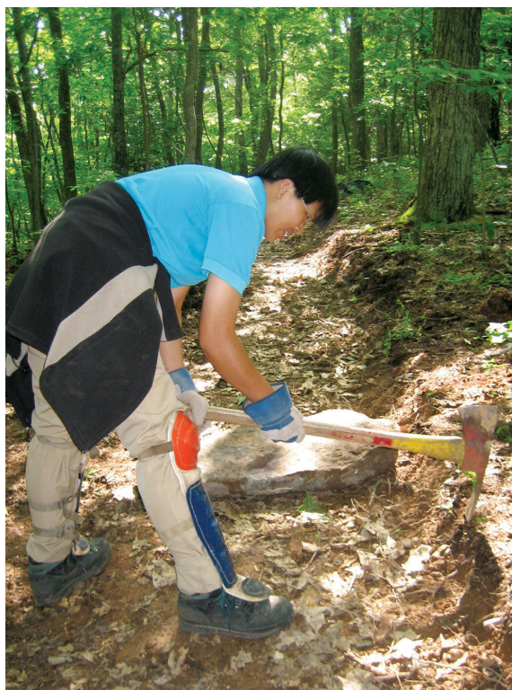
▲運用當地找到的石材，挖掘適合石頭形狀的擋水石階埋設點，取之自然，做過不留痕跡。
